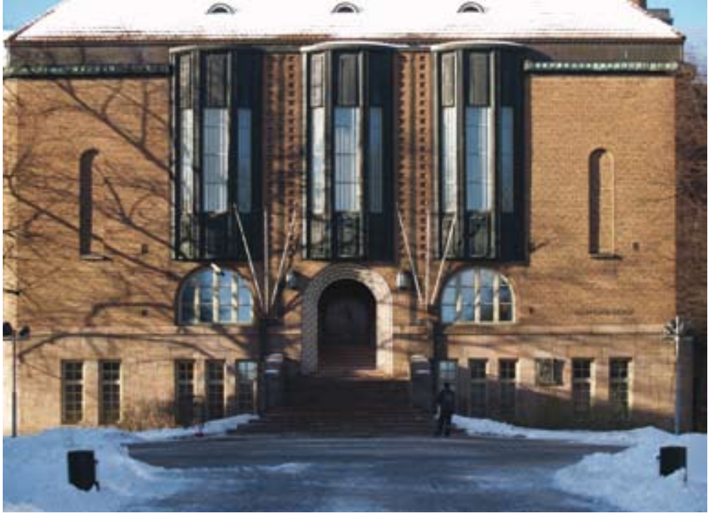
Lahden kaupungintalon pääjulkisivu. Kuva Lauri Putkonen.
