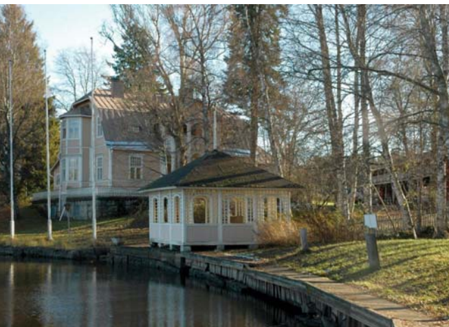
Entisen kauppias Pulkkisen huvilan ranta on rakennettu kiviarkkoista 1900-luvun alussa. Kuva: Kirsti Kovanen.
