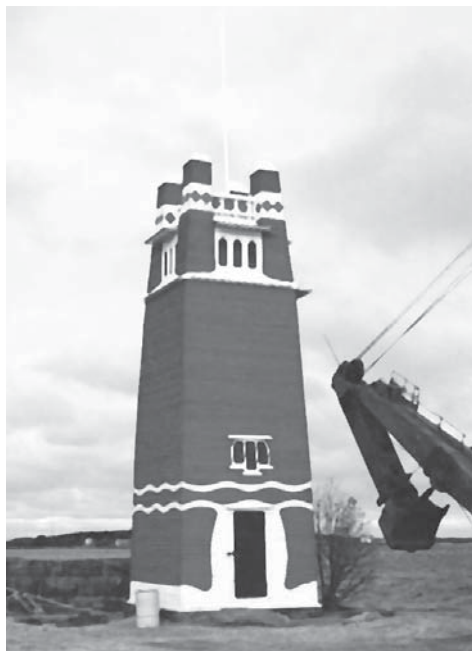
Mäntyluodon pooki, ”Ryssäntorni”. Porin kaupungin omistaman pookin, tunnusmajakan, suunnitteli Gustaf Nyström ja se valmistui 1903 tärkeimpien satamatöiden tultua Mäntyluodossa tehtyä. Kuva: Jarmo Saarinen.
