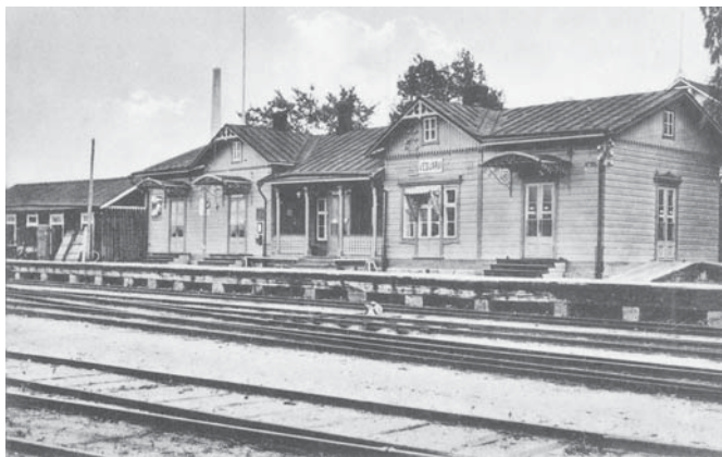
Vesijärven asema edusti Valtionrautateiden suunnittelijan Knut Nylanderin tyyppiirustusta numero neljä. Asemarakennus oli epäsymmetrinen, yksikerroksinen ja siinä oli suurehko sisäänvedetty avokusti ja koristeellisia puuleikkauksia. Ympäristöön rakennettiin rautatiehäisten asuintaloja. Pian aseman äärelle tuli myös ravintola ja kioski. Postikortti: Vesijärven asema 1920- tai 1930-luvulla. Lahden kaupunginmuseon kuva-arkisto.
