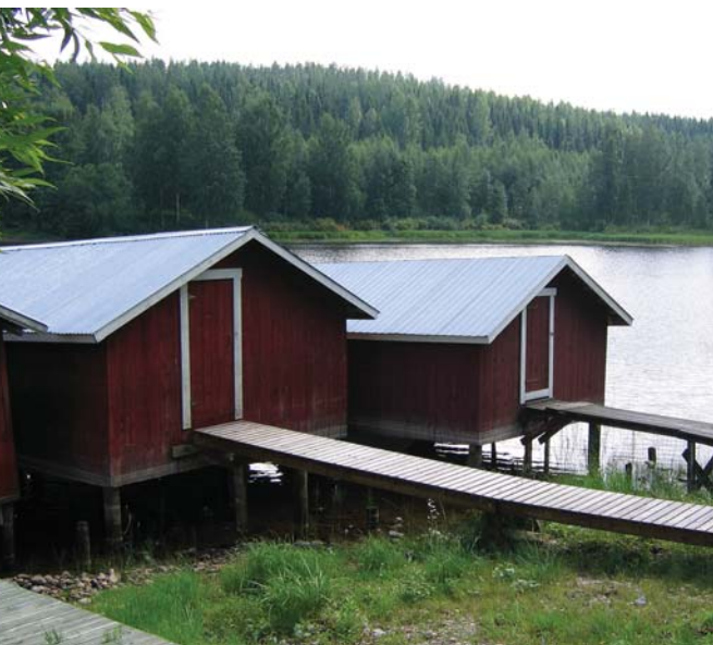
Vesireitit ovat maailman vanhimpia infrastruktuureja. Virroilla sijaitseva venevaja on muinaisen vesiliikenteen synnyttämä rakennustyyppi, joka on vieläkin käytössä. Kuva: Ari Hynynen, 2005.
