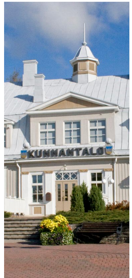
Punkalaitumen kunnantalo, Kuva: Juha Aro.
