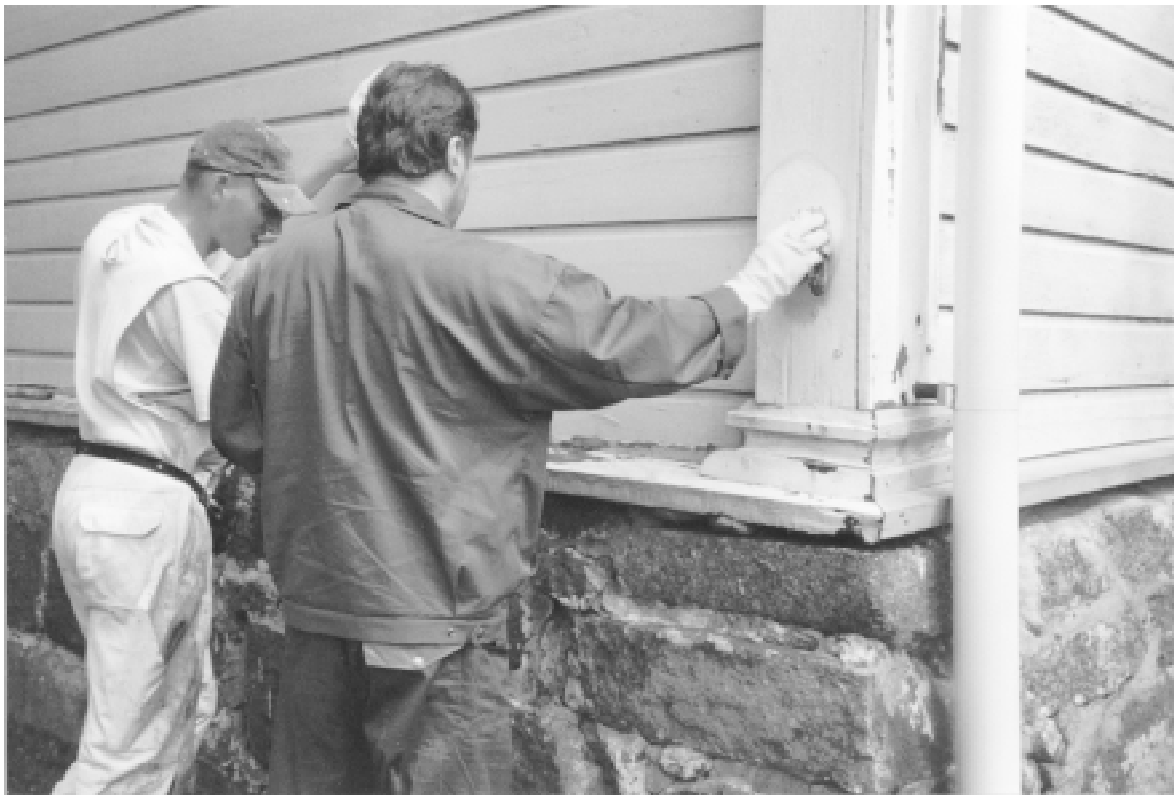
Ennen ulkomaalausta tehtiin puuosien korjaukset ja pyrittiin tutkimaan entiset maalikerrostumat. Kuva: Pirkko Anttila.
