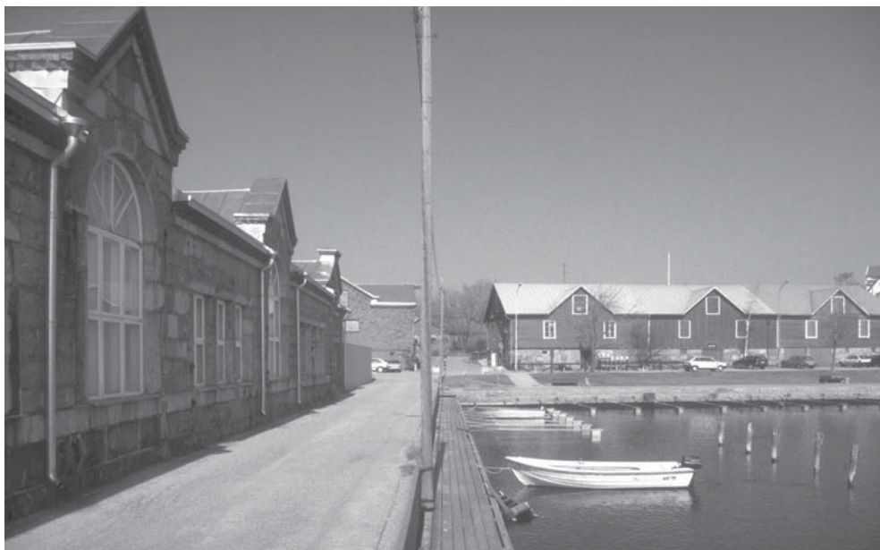
Hangon itäsatama on maan suurin vierassatama. Satama-allasta reunustavat Granit-yhtiön vanhat tehdasarakennukset sekä 1800-luvun lopun makasiinit, jotka ovat pääosin ravintolakäytössä. Kuva: Lauri Putkonen.
