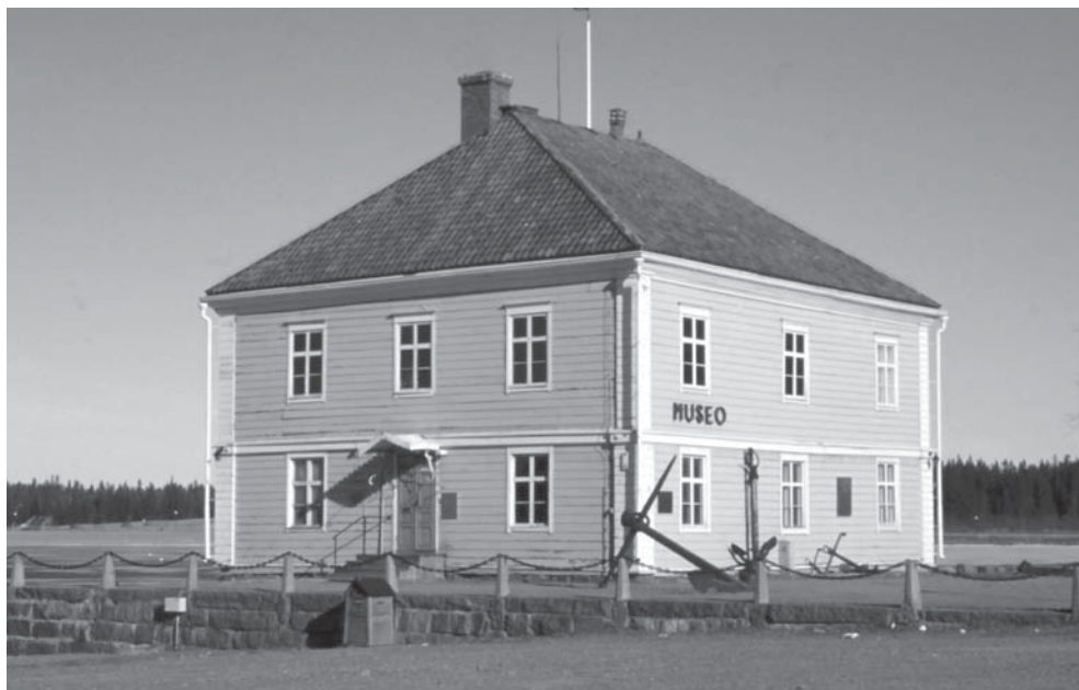
Raahen vanha pakkahuone muistuttaa yhä ajasta, jolloin purjelaivat kuuluivat kaupunkikuvaan. Museokäytössä rakennus on ollut jo vuodesta 1909. Kuva: Lauri Putkonen.
