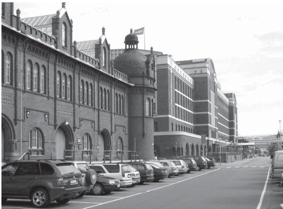
Katajanokan tulli- ja pakkahuone samoin kuin taustalla näkyvä entinen Warranttimakasiini ovat saaneet satamaympäristöön luontevasti liittyvän käytön. Kuva: Lauri Putkonen.
